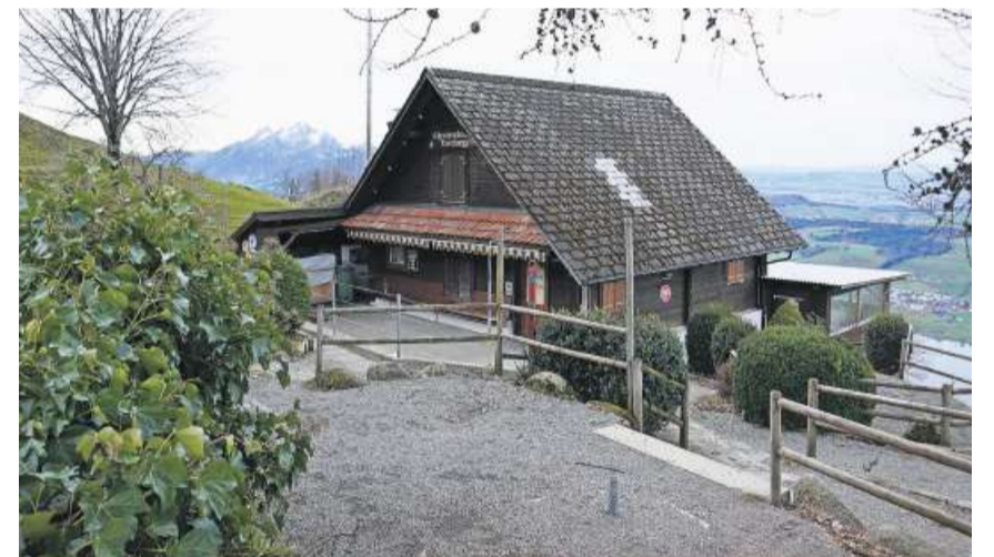
Die Alpwirtschaft wird auf den Stand von 1970 zurückgebaut. Im heutigen Zustand genügte sie den gesetzlichen Anforderungen nicht mehr. Bild: Monika Neidhart
